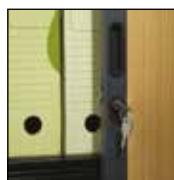
Serrure à crochet montée sur une lame en acier
